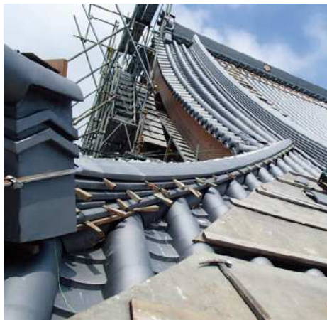
瓦は組み合わせを考えひとつひとつ勾配を決めながら積んでいく。くさびは自作し間隔によって寸法を変えている
